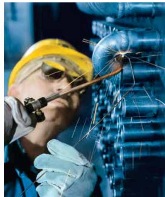
Lämmönvaihtimen kaasuhitsaustyö.
